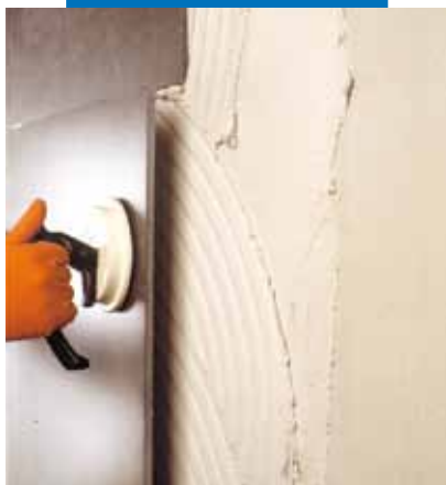
Pose de grès Cérame de grand format avec Elastorapid sur une façade en béton
