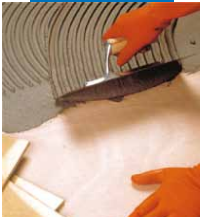
Pose de grès cérame avec Elastorapid sur panneau bois
