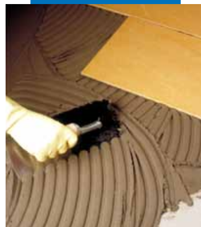
Application d'Elastorapid avec une taloche demi-lune sur chape ciment
